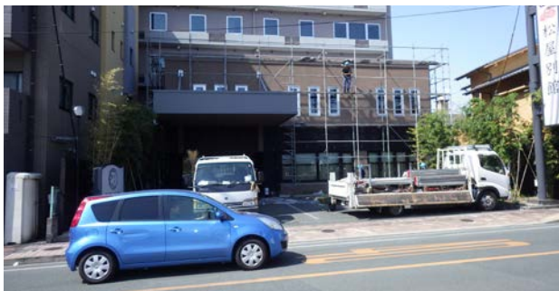
復旧工事中の組合員施設
